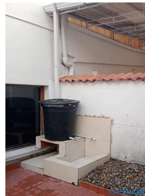
Imágen Instalación y adecuación de un tanque para aprovechamiento de aguas lluvias en la sede calle 69
